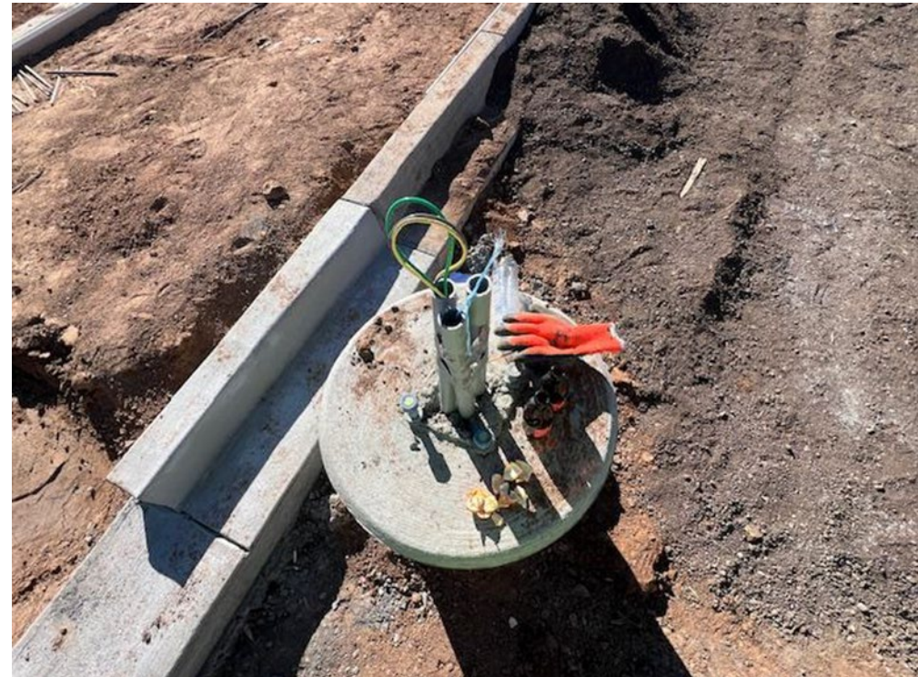
Light Pole Base and Conduit
